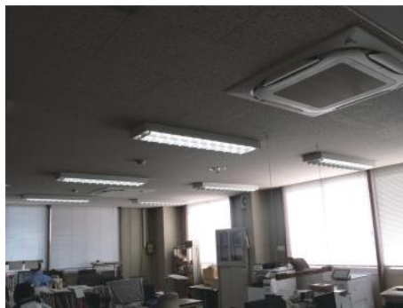
▲事務所LED照明新設エアコン
