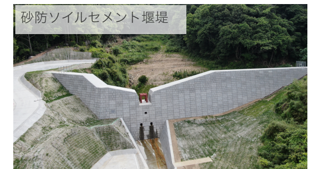
砂防ソイルセメントによる防草工
