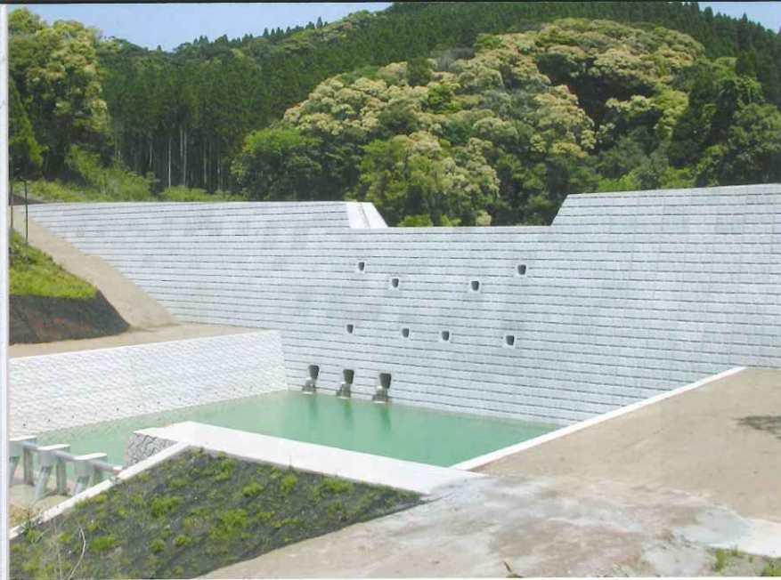
ソイルセメント工法で施工された砂防
