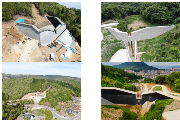
図：平成30年 西日本豪雨災害復旧事
