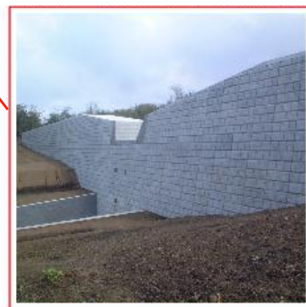
H16 日本最古SBウォール堰堤 三宅島しらみ沢遊砂池堰堤
