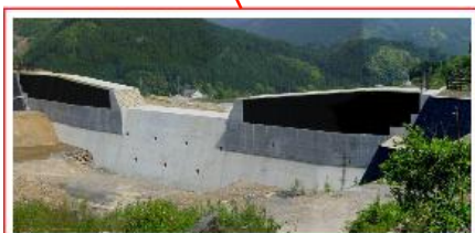
H16 緩衝工事例 集川1号砂防堰堤
