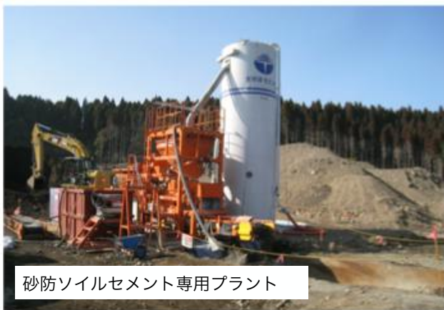
砂防ソイルセメントによる既設堰堤の増強
