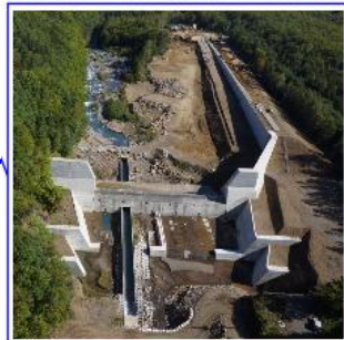
H24 美瑛川第1号導流堤
